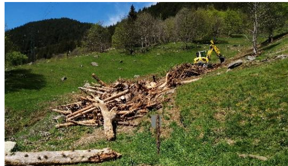
Travaux suite à une avalanche – AFP du Rivier d'Allemond
